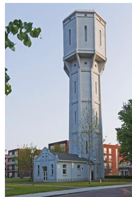
De watertoren aan de Nijverheidsweg met links het pomphuis
