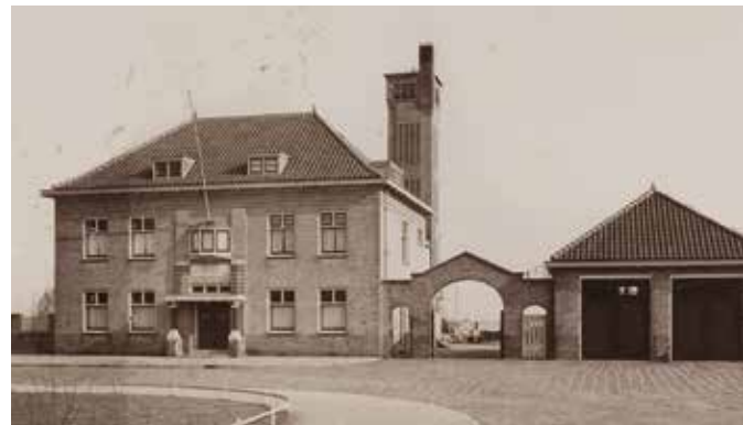
▲ In de toren bij het gebouw van Openbare Werken aan het Wipperplein werden de brandslangen van hennep gedroogd, rechts de garage voor het materieel van de brandweer. Foto 1932.
