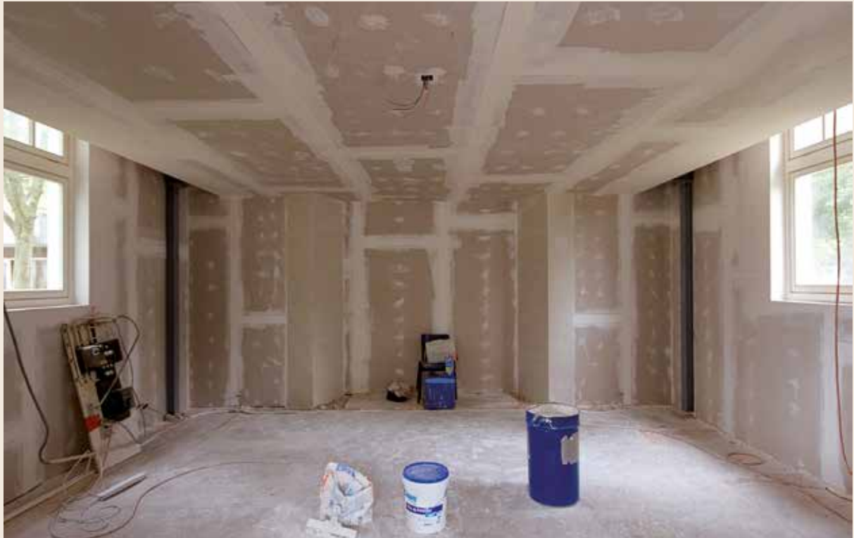
Tijdens de verbouwing in het pomphuis, eind juni 2017.
